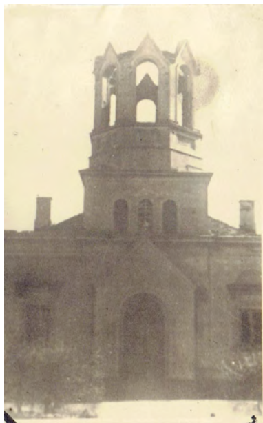
Dawna siedziba ewangelickiego duszpasterstwa w Warszawie przy ul. Puławskiej (1945)
